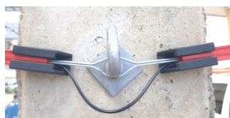
รูปที่ 9 การติดตั้งใช้งานอุปกรณ์จับยึดเคเบิลสายกระจาย
